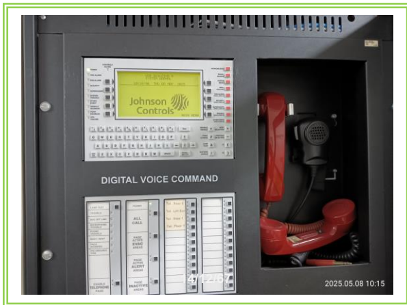
รูปที่ 3-65 แผงควบคุม (FCP)
