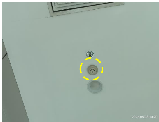
รูปที่ 3-44 เครื่องตรวจจับควัน (Smoke Detector) ภายในห้องเครื่องหม้อแปลงไฟฟ้า
