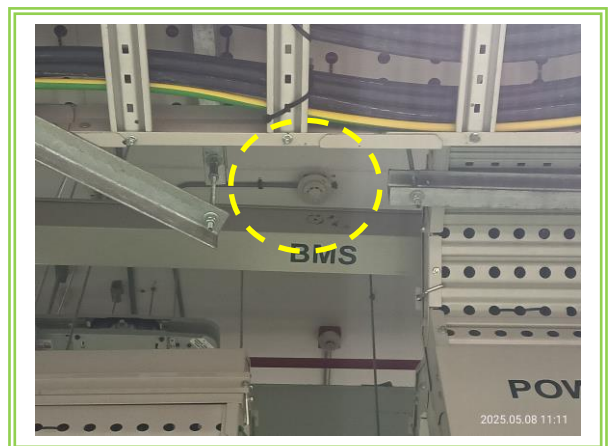
รูปที่ 3-66 เครื่องตรวจจับควัน
