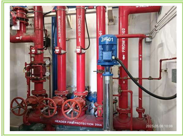
รูปที่ 3-59 ระบบท่อเย็น (Stand Pipe)
