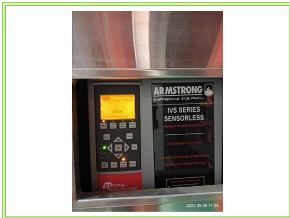
รูปที่ 3-57 มอเตอร์ VSD เพื่อลดการใช้พลังงานไฟฟ้าที่เครื่องสูบน้ำ
