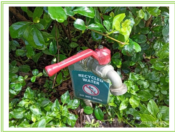
รูปที่ 3-14 ก๊อกน้ำสำหรับน้ำเสียที่ผ่านการบำบัดกลับมาใช้รดต้นไม้ของโครงการ
